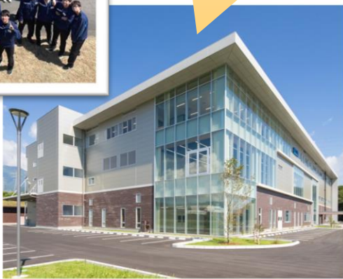
開発生産棟 竣工
